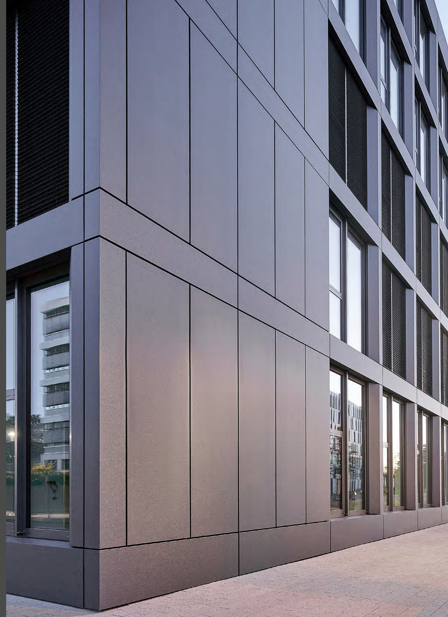
The surfaces and joints in the ALUCOBOND® façade follow the floor slabs and layout grid. Die ALUCOBOND®-Fassade zeichnet mit Fläche und Fugen Geschossdecken und Grundrissraster nach.
