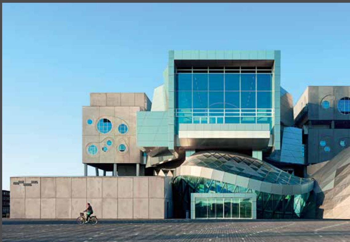
Die Fassade aus ALUCOBOND® PLUS Aluminiumverbundplatten in naturAL Brushed verleiht dem Gebäude einen individuellen Charakter. | Bilder: Duccio Malagamba
