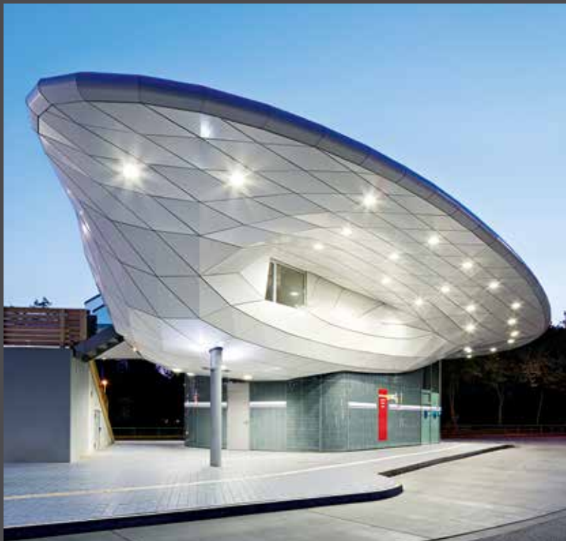
Das schwebende Flügeldach des Busbahnhofes Hamburg Poppenbüttel aus ALUCOBOND® PLUS Reinweiß. | Bild: archimages
