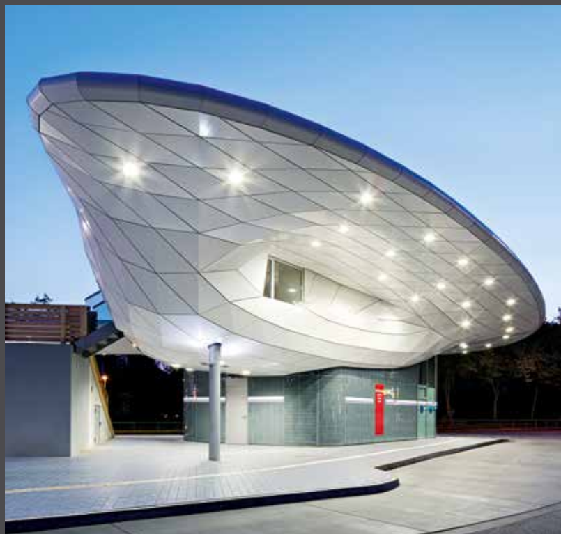
L'aileron flottant de la gare routière Hamburg Poppenbüttel en ALUCOBOND® PLUS Pure white. | Image : archimages
