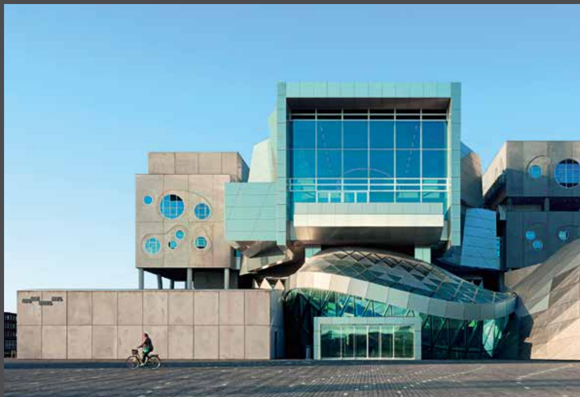
La façade en panneaux composites aluminium ALUCOBOND® PLUS naturAL Brushed confère au bâtiment son caractère individuel. | Images : Duccio Malagamba
