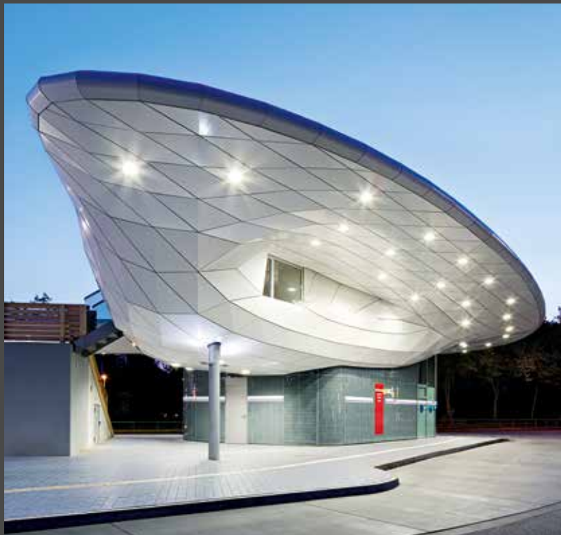
O teto em forma de asa flutuante da Estação Rodoviária Poppenbüttel, executada em ALUCOBOND® PLUS pure white. | Imagem: archimages
