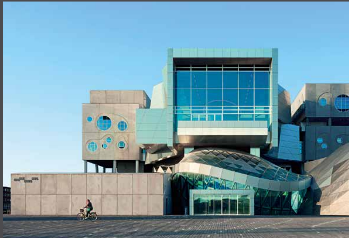
Фасад из алюминиевых композитных панелей ALUCOBOND® PLUS naturAL Brushed придает зданию индивидуальный характер. | Фото: Duccio Malagamba
