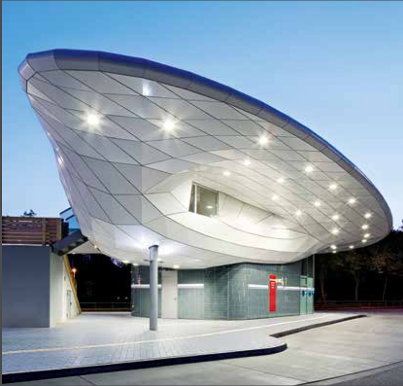
Парящая крыша автовокзала Hamburg Poppenbüttel из ALUCOBOND® PLUS. Фото: archimages
