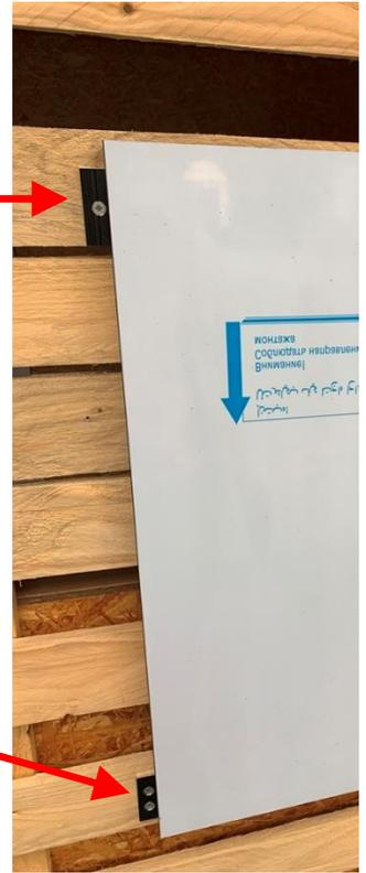
**2 Schrauben für das Starterprofil unten**
