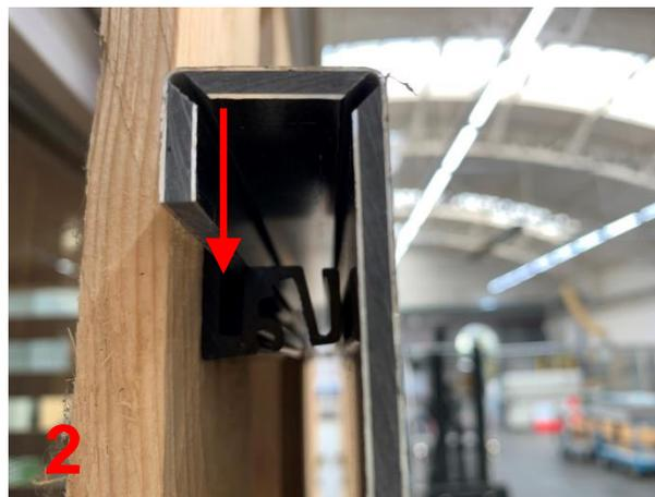
Setzen Sie die Profile in die untere Falte ein und schieben Sie sie vor die Halterung
