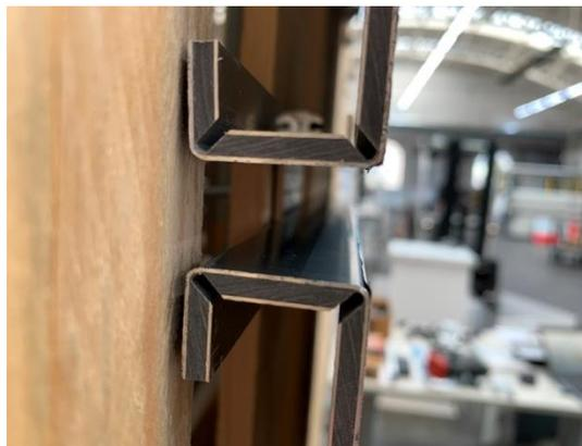
Setzen Sie das Endprofil in die untere Falte ein und schieben Sie es vor die Halterung
