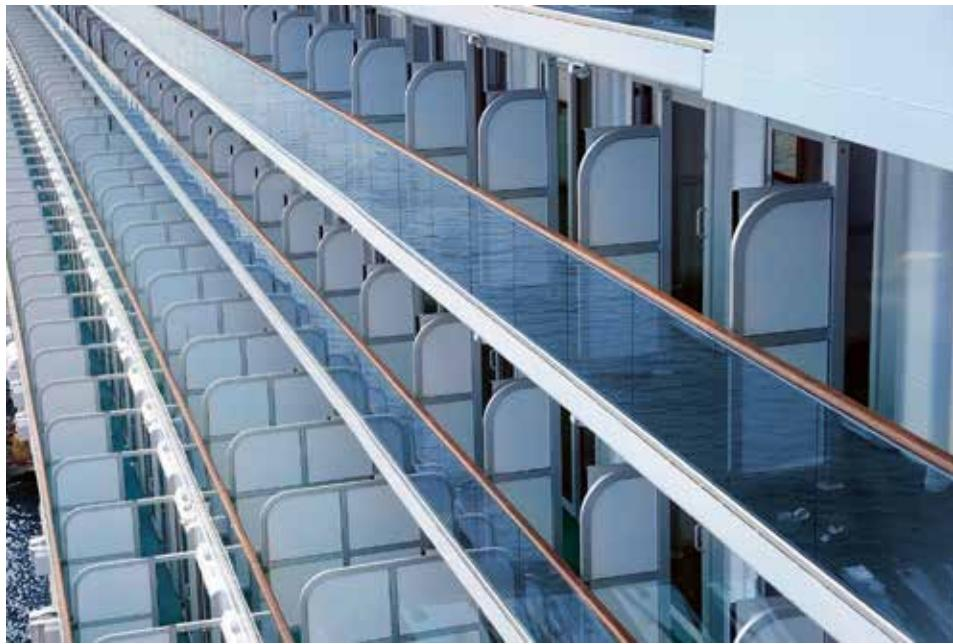
Экономично – устройство перегородок балконов при помощи ALUCORE®
