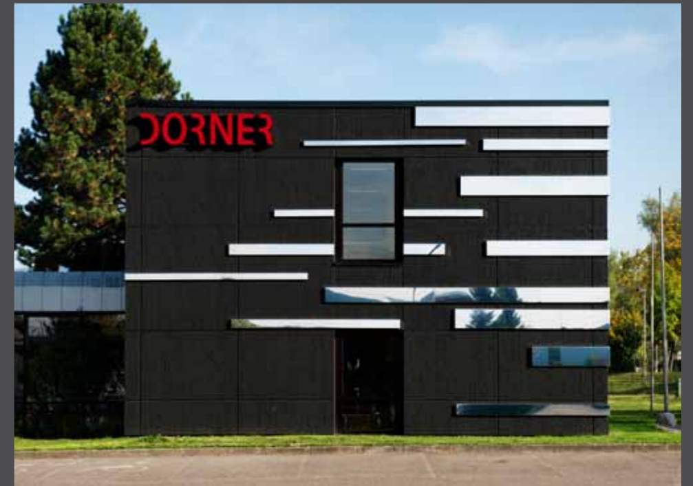
The concrete was painted black. Der Beton erhielt einen schwarzen Anstrich.
