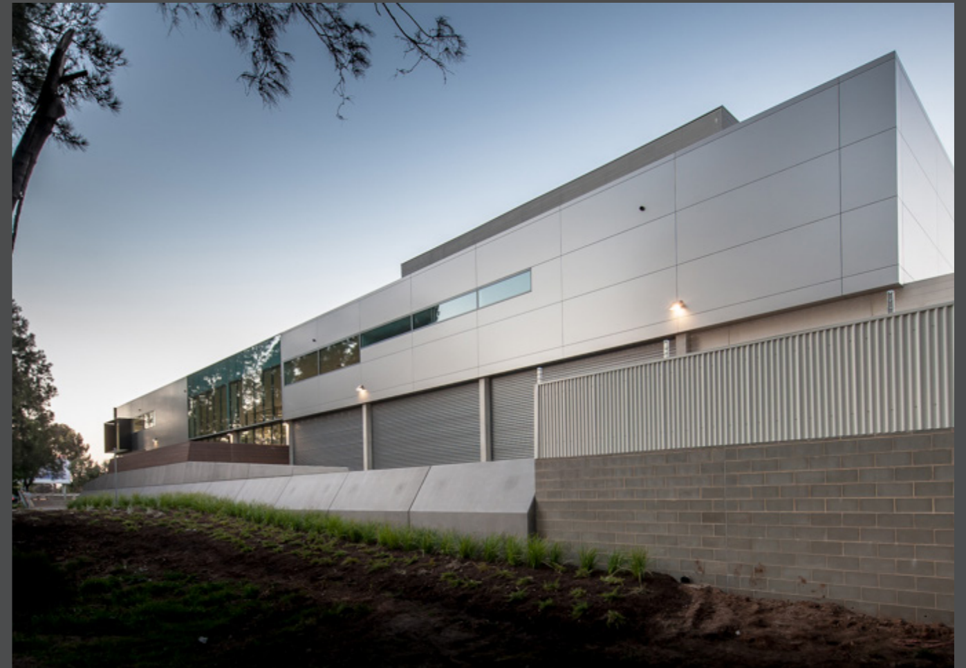
The rear side of the police station with its large ramp. Die Rückseite des Polizeireviers mit der großen Rampe.
