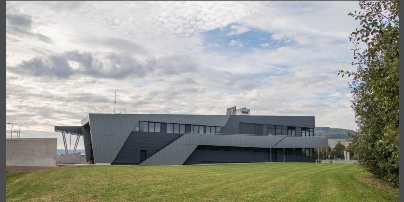
The wedge-shaped design facilitates the use of space where high ceilings are required. Durch die keilförmigen Gebäudeteile wird die optimale Ausnutzung der Höhen ermöglicht.
