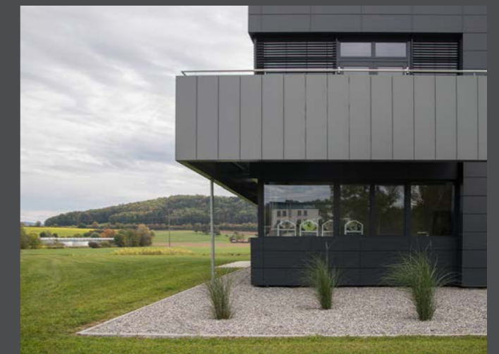
The vertical cladding of the balcony contrasts to the horizontally cladded façade. Die Vertikalverlegung an den Balkonen bildet einen Kontrast zur horizontalen Verlegung an der Fassade.
