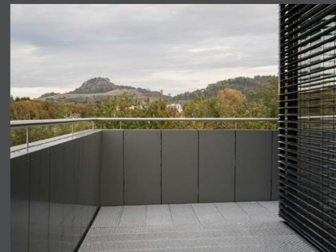
The vertical cladding of the balcony contrasts to the horizontally cladded façade. Die Vertikalverlegung an den Balkonen bildet einen Kontrast zur horizontalen Verlegung an der Fassade.
