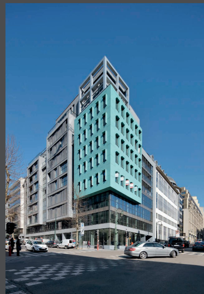
A touch of nostalgia: ALUCOBOND® composite panels cladding the living accommodation in the middle floors are reminiscent of old Brussels with its weathered copper and sun awnings. Ein Hauch von Nostalgie: Die ALUCOBOND®-Verbundplatten, mit denen die mittleren Wohngeschosse verkleidet sind, erinnern leicht an das alte Brüssel samt verwittertem Kupfer und Sonnenmarkisen.
