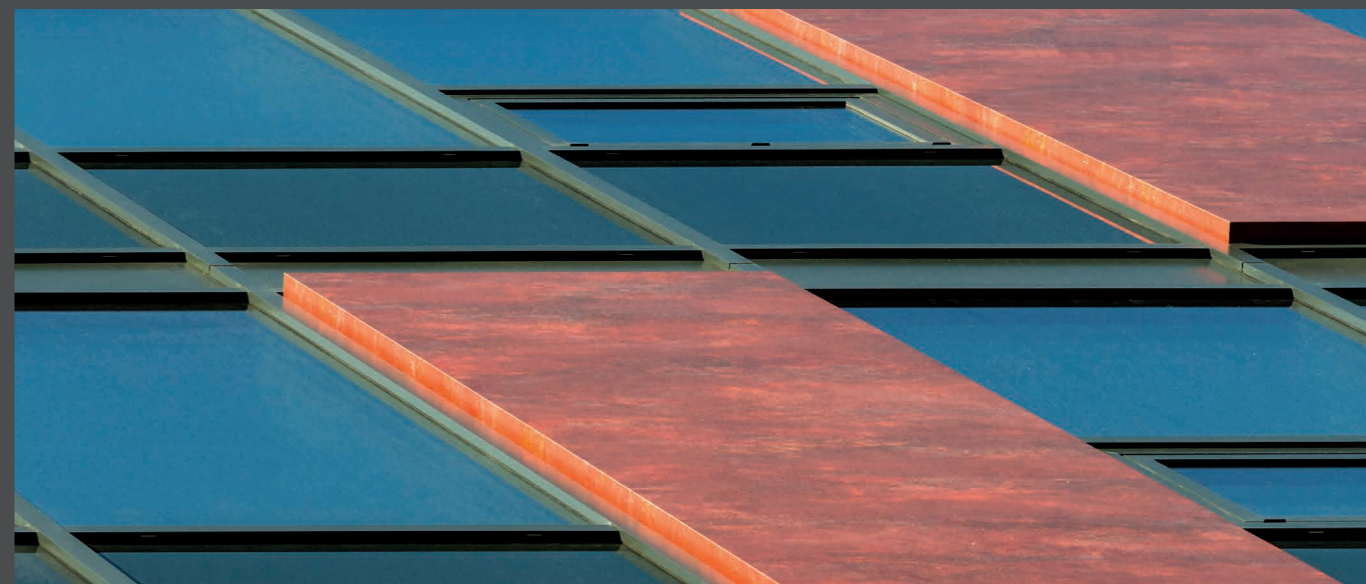
Rusty ALUCOBOND® composite panels reminiscent of the red of old town roofs and steel Soviet buildings in Bratislava. | Rostrote ALUCOBOND®-Verbundplatten als Reminiszenz an die roten Altstadtächer und stählernen Sowjetbauten in Bratislava.
