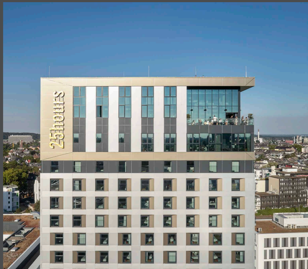
Added sheen and depth: window reveals and the crest of the building in gold metallic ALUCOBOND® composite panels. | Mehr Glanz und Tiefe: Gewände und Krone mit metallisch goldenen ALUCOBOND®-Verbundplatten.
