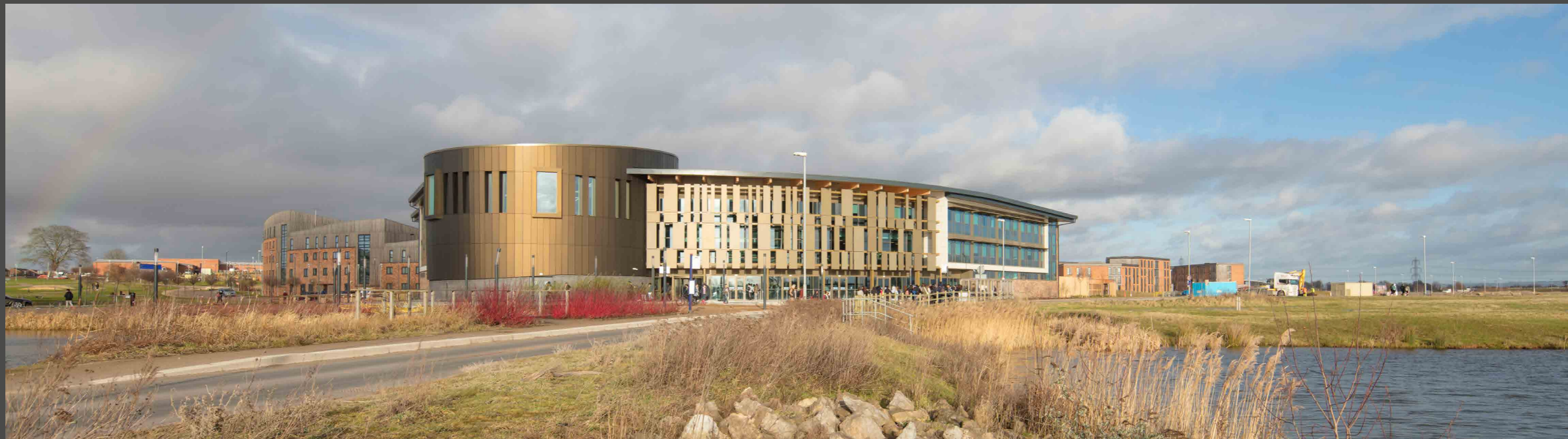
The colour of autumn grass: Façade cladding, sun protection and window elements, all in ALUCOBOND® terra Pyrite. Die Farbe von Herbstgras: ALUCOBOND® terra Pyrite als Fassadenverkleidung, als Sonnenschutz und als Fensterelement.
