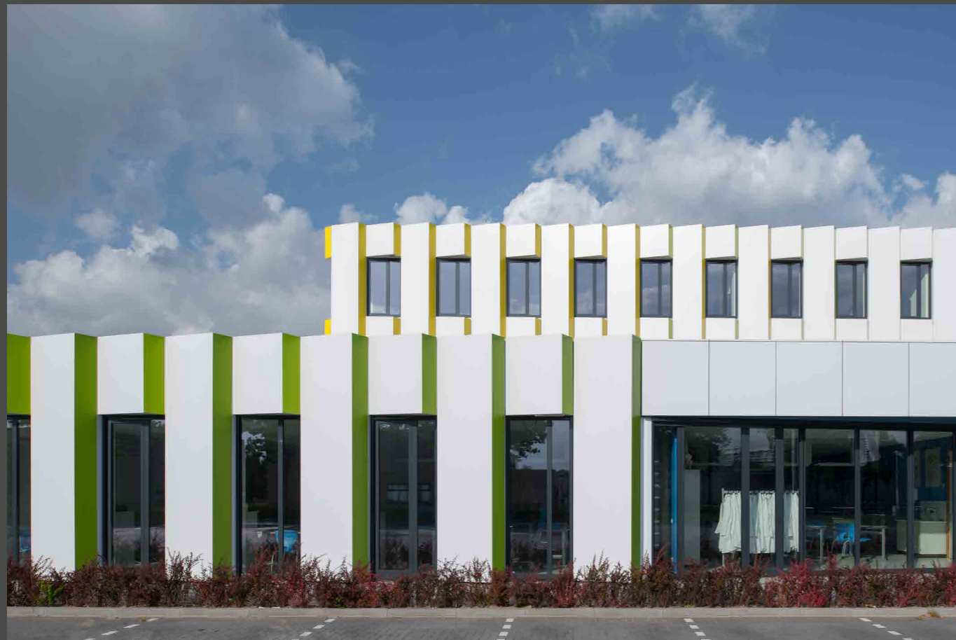
Secondary and grammar schools are on separate storeys; this divides the large volume into more manageable units. Mittel- und Oberschule sind geschossweise voneinander getrennt; so werden aus dem großen Volumen überschaubare Einheiten.
