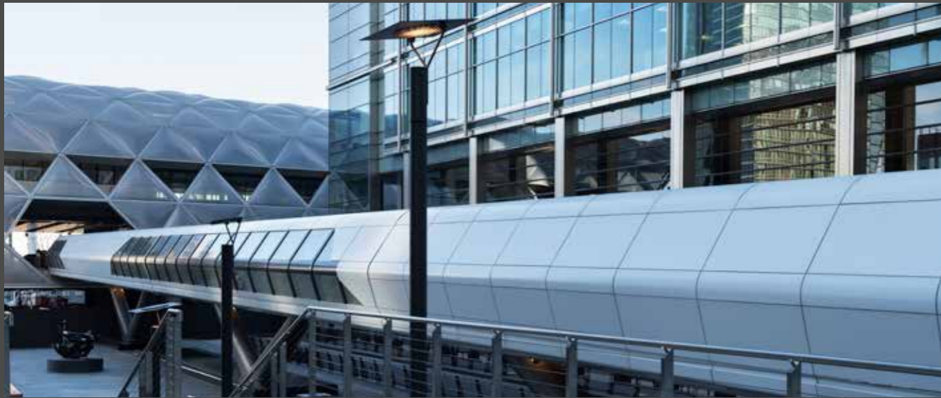
Three times standard format; three times different: the station's air cushion roof, the office building's glass façade and the folded ALUCOBOND® soffit cladding on the footbridge as connecting element in front. | Dreimal seriell, dreimal anders: das Luftkissendach der Station, die Glasfassade des Bürogebäudes und als verbindendes Element davor, die gekantete ALUCOBOND®-Fassade der Fußgängerbrücke.
