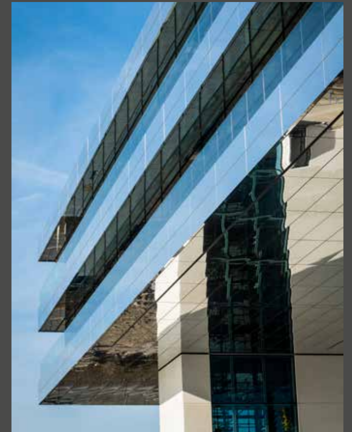
73 metres between the walls which support and link the narrow structure. | 73 Meter liegen zwischen den Kernen, die den Riegel erschließen und stützen.
