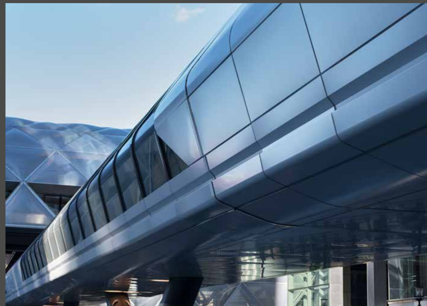
Office to station: the footbridge stops you getting wet feet on the way. Die Brücke zur Station ermöglicht trockenen Fußes vom Büro zur U-Bahn zu gelangen.
