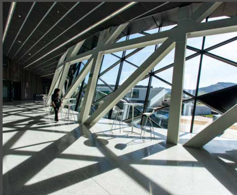
The building's leaning form enhances its own shade on the south-facing side and creates a feeling of seclusion in the courtyard... Die Neigung des Baukörpers erhöht die Eigenverschattung der Südseite, schafft eine intime Atmosphäre im Hof...
