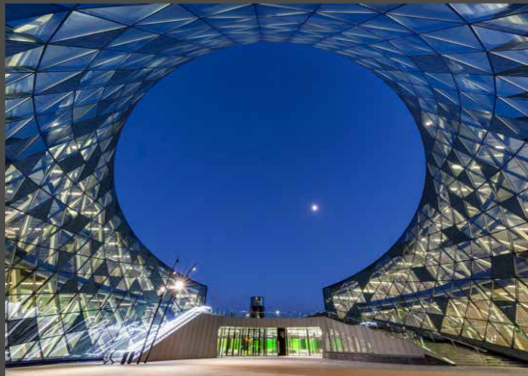
The building's leaning form enhances its own shade on the south-facing side and creates a feeling of seclusion in the courtyard... Die Neigung des Baukörpers erhöht die Eigenverschattung der Südseite, schafft eine intime Atmosphäre im Hof...
