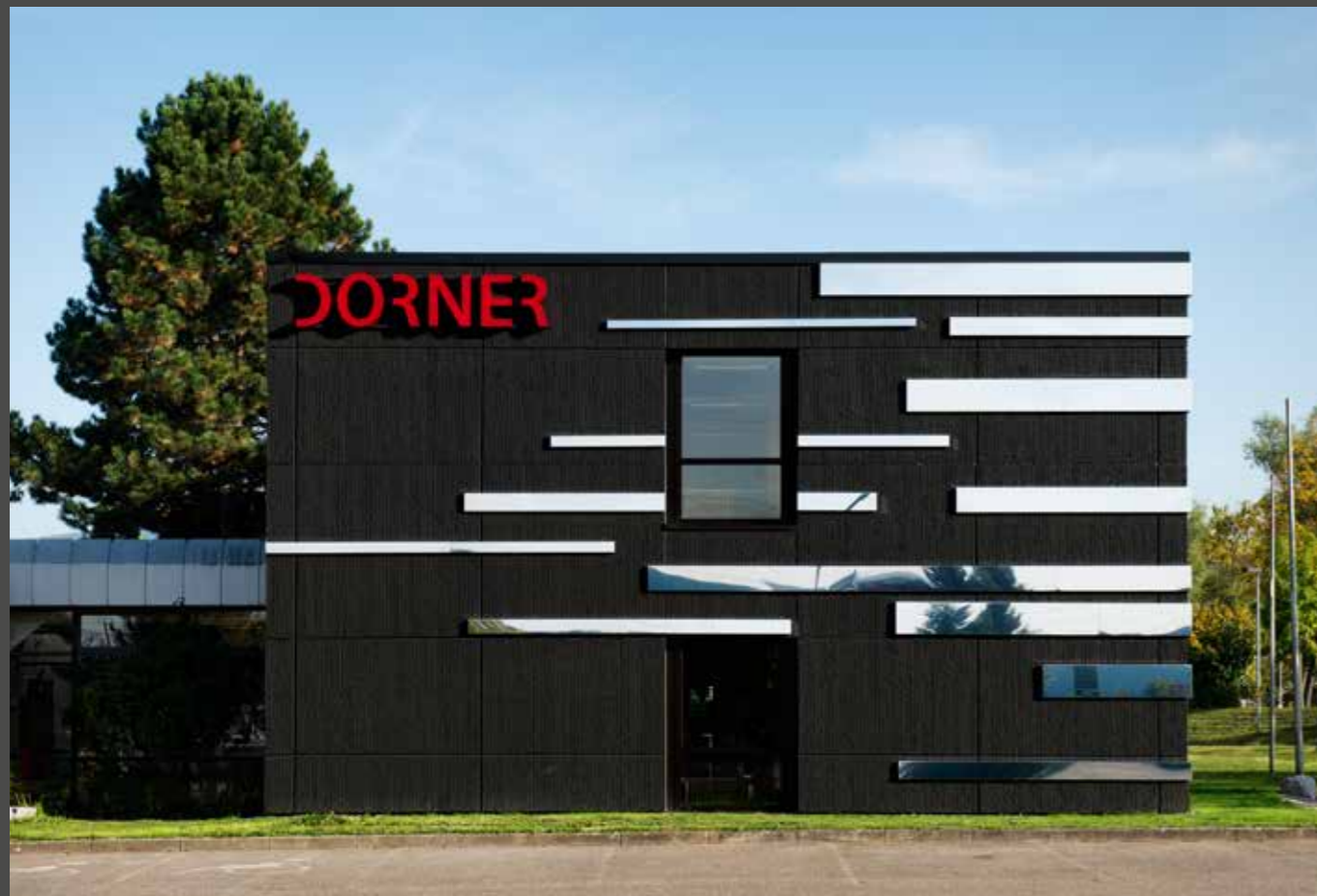
The northern side of the building is connected to the rest of the building complex, while the southern side seems to dematerialise in reflections. | Die nördliche Gebäudeseite schließt an den restlichen Baukomplex an, die südliche scheint sich in der Reflexion zu entmaterialisieren.
