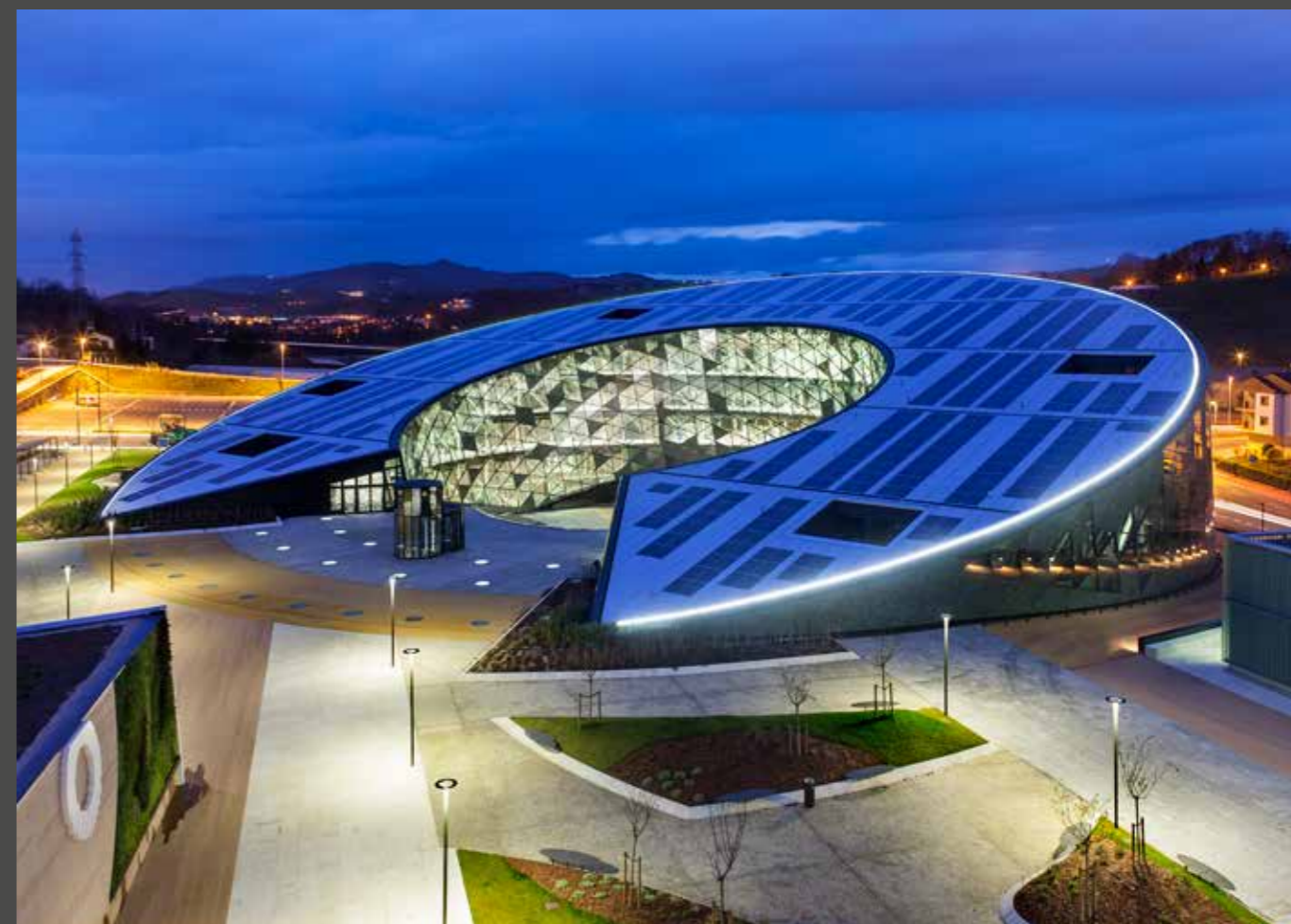
The pitch of the roof is ideal for the 1,000 polycrystalline photovoltaic modules and for the calculated zero-energy balance, too. Die Neigung ist optimal für die 1.000 polykristallinen PV-Module auf dem Dach und damit für die rechnerische Null-Energie-Bilanz.
