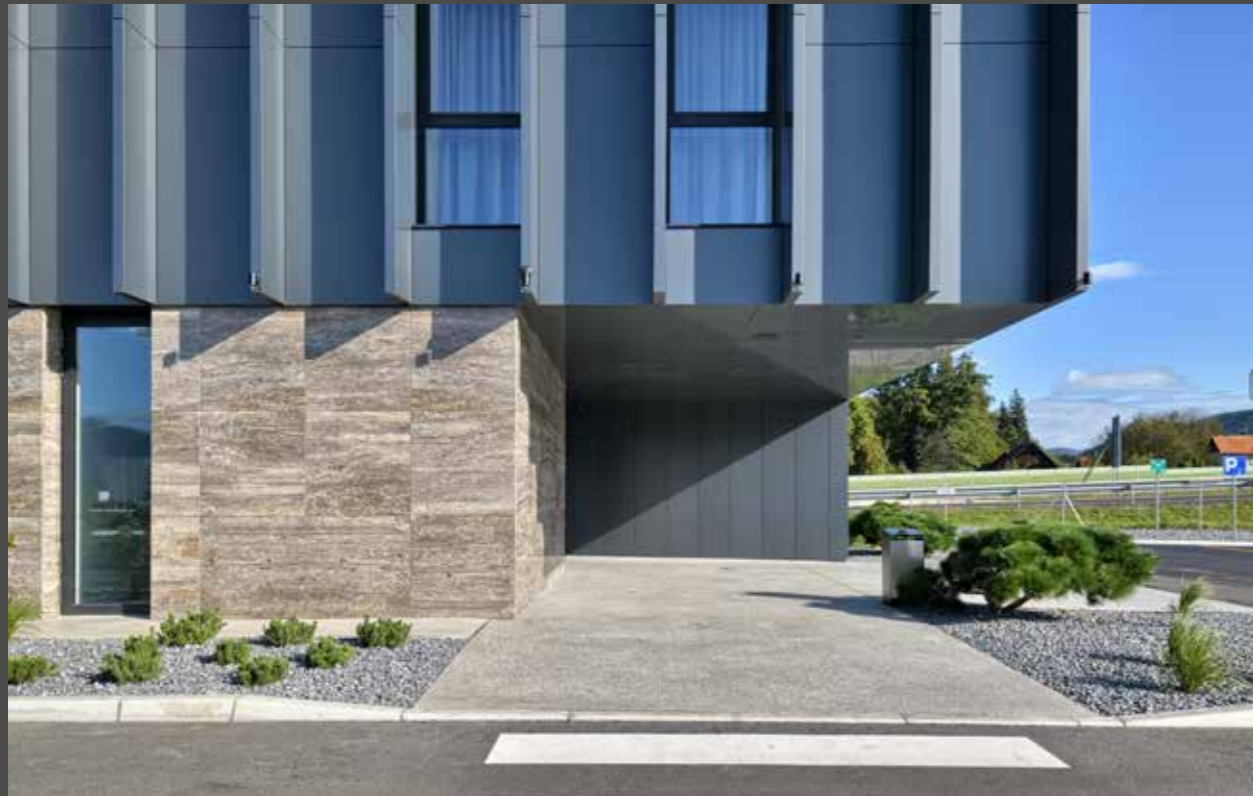
The folding in the ALUCOBOND® façade provides seclusion and sun protection – and an austere look of modernity. Die Faltung der ALUCOBOND®-Fassade sorgt für Intimität und Sonnenschutz – und für den Look einer strengen Moderne.
