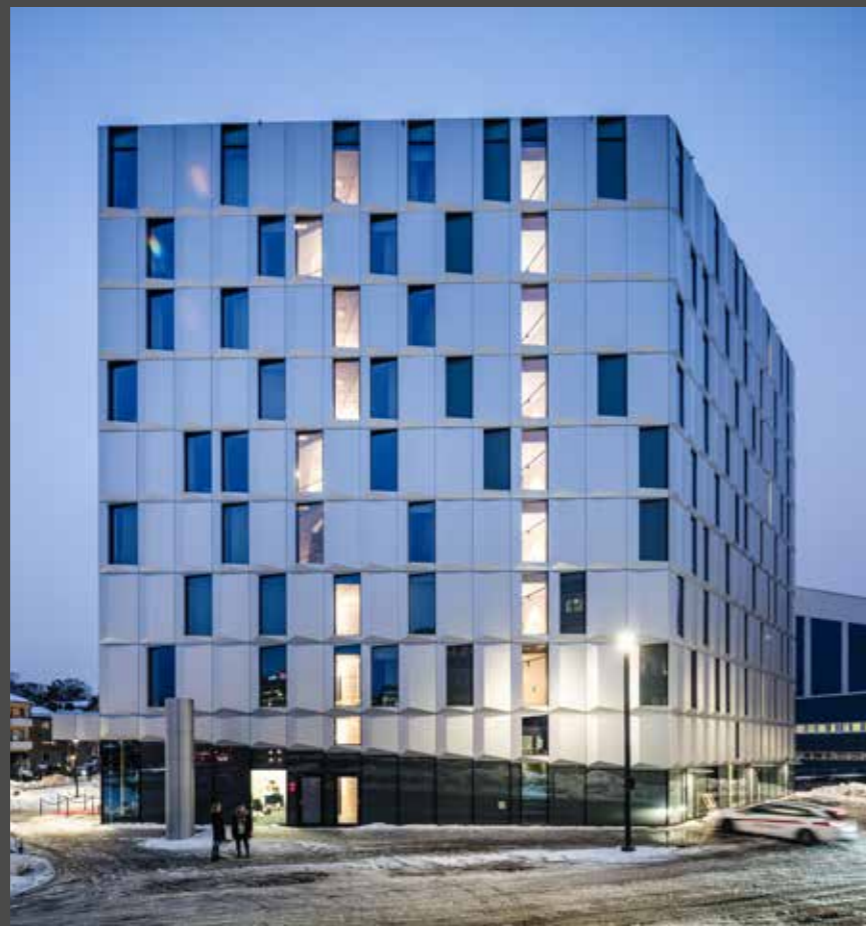
Three metres of façade for each guest: But these are divided into open and closed sections of varying widths to ensure the façade is not monotonous. | Drei Meter Fassade für jeden Gast: Die aber teilen sich in unterschiedlich breite, offene und geschlossene Felder und verhindern so Monotonie in der Fassadenansicht.
