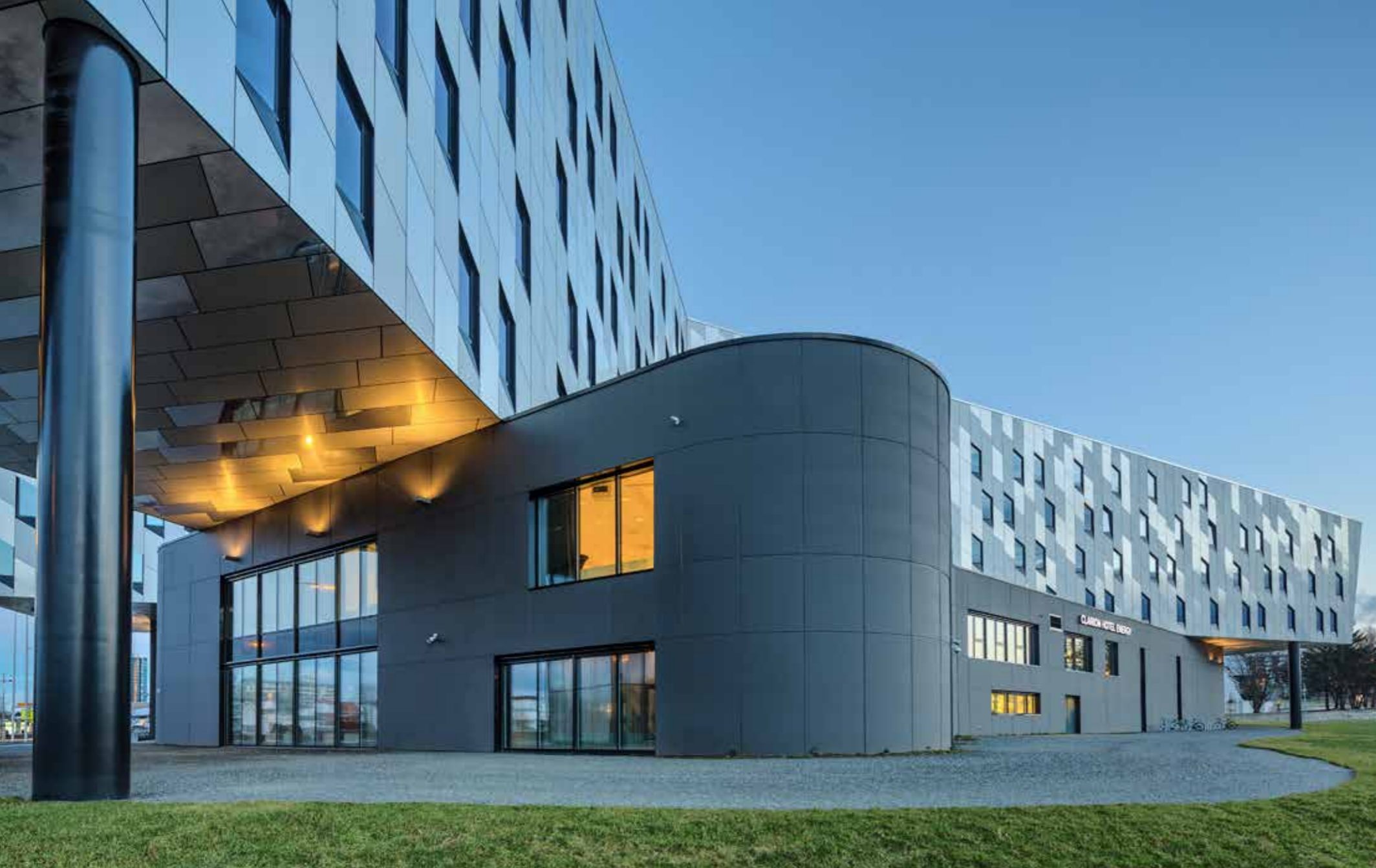
Different appearance reflects different functions: Below a concrete clad base; above a variety of ALUCOBOND® panels clad the storeys offering accommodation. | Der funktionalen Trennung folgt eine optische: Der Sockel ist mit Beton verkleidet, die Wohngeschosse darüber mit verschiedenen ALUCOBOND®-Platten.
