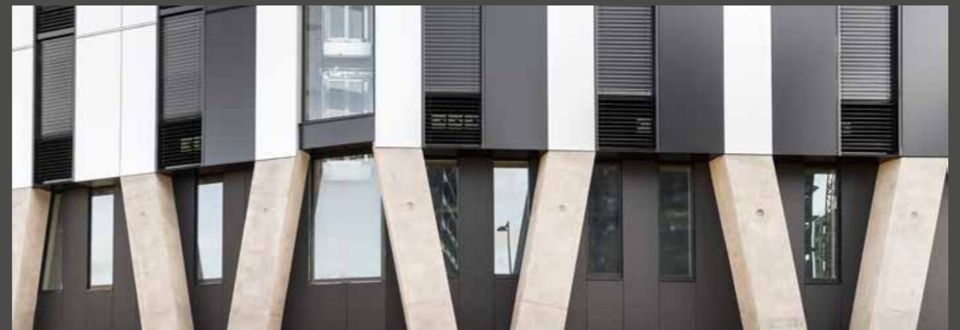
Residential floors clad in a mosaic of ALUCOBOND® tray panels and PV panels. The office floors are located behind the concrete columns on the two base floors. | Die Wohngeschosse kleidet ein Mosaik aus ALUCOBOND®-Kassetten und PV-Paneelen. Hinter den Betonstützen der zwei Sockelgeschosse liegen die Büroetagen.
