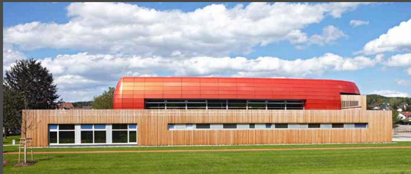
The base in a regional wooden façade, the ALUCOBOND® spectra Cupral dome, a colour highlight visible from afar. Der Sockel in regionaler Holzfassade, die Haube als weithin sichtbarer Farbakzent mit ALUCOBOND® spectra Cupral.
