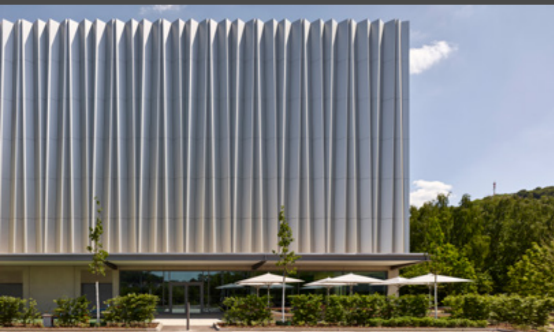
The three-dimensional folds in the curtain are lightly tilted. The façade is turned into an elaborate puzzle of different individual pieces. Die Faltungen des Vorhanges verlaufen dreidimensional geneigt. Damit wird die Fassade zu einem aufwendigen Puzzle aus unterschiedlichen Einzelteilen.
