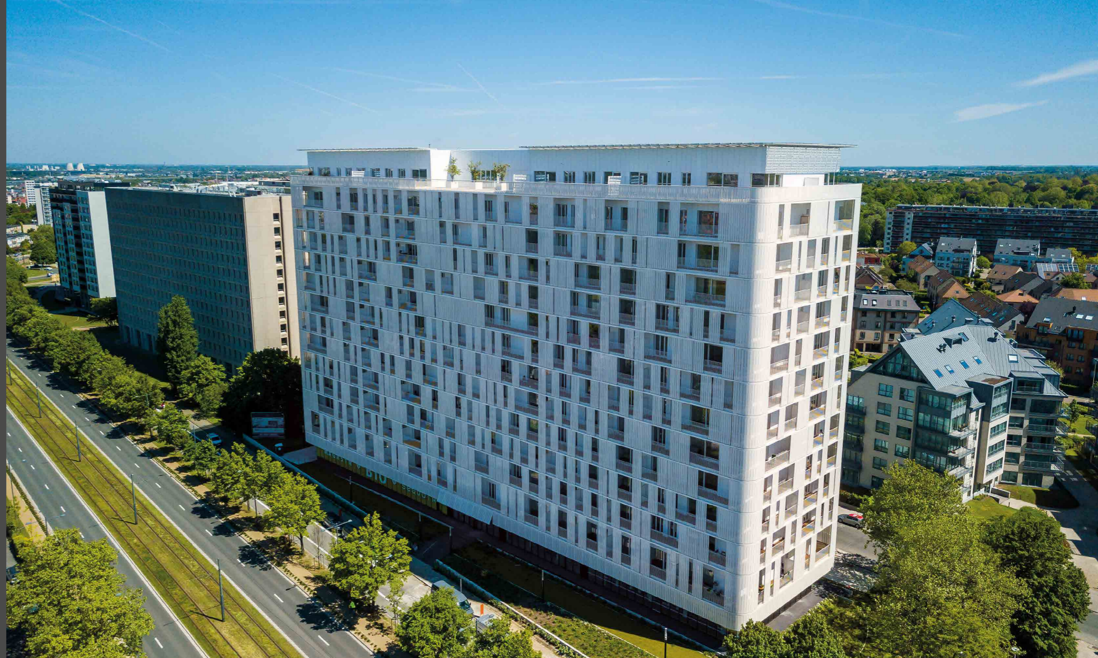
The sun shading elements protect against wind, the sheer drop and enhance privacy, making the balcony feel more comfortable. Viewed from the outside, they create a more fitting scale and better relationship with the neighbourhood. Die Sonnenschutzelemente schützen vor Wind, Einblicken und dem Abgrund und sorgen so für ein besseres Gefühl auf dem Balkon. Von außen betrachtet sorgen sie für eine bessere Maßstäblichkeit und Beziehung zur Nachbarschaft.
