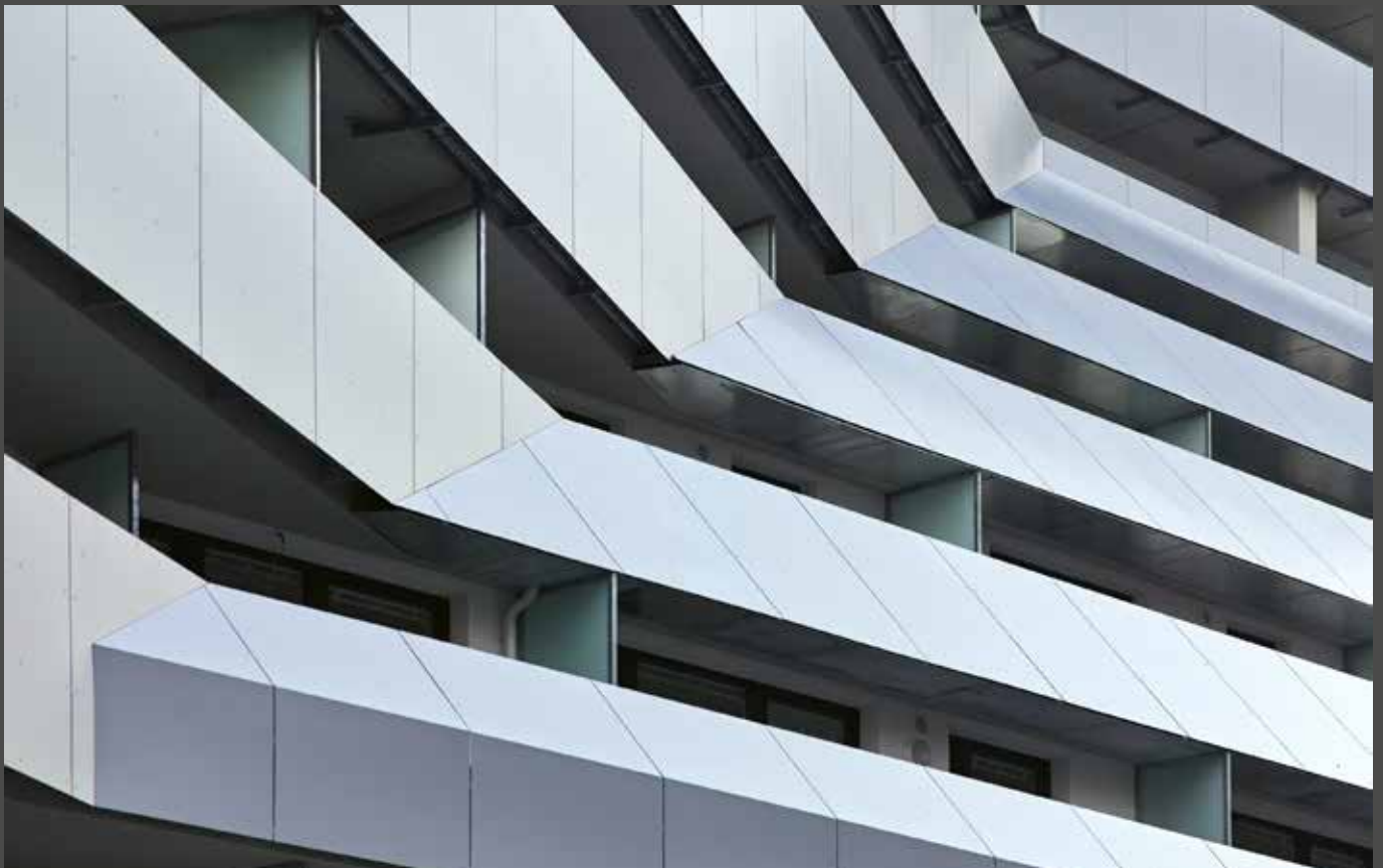
View from the street. Blick von der Straße.
