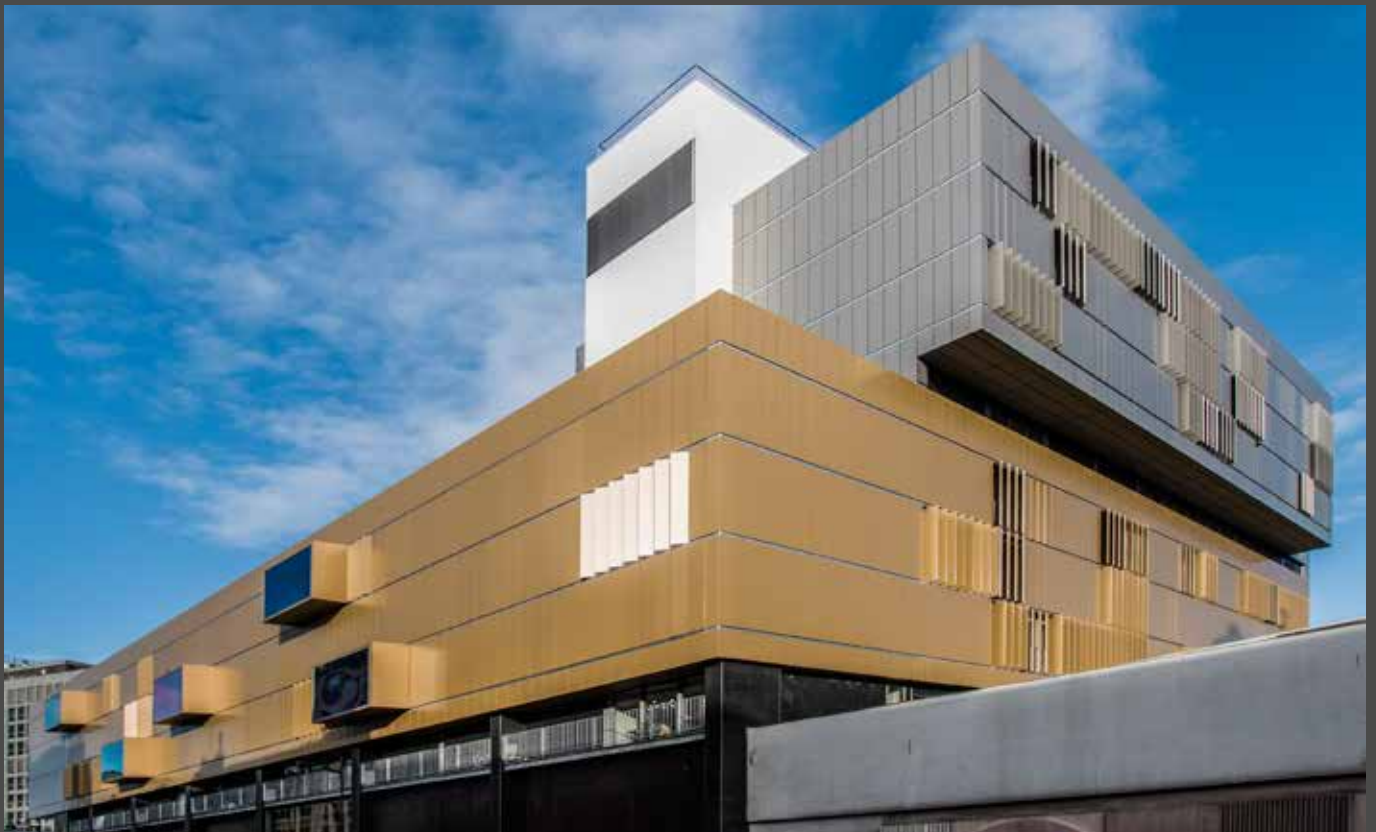
The extraordinary façade enhances the surrounding area. Die außergewöhnliche Fassade wertet die Umgebung auf.
