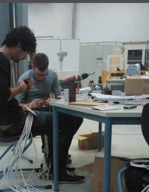
Beleuchtung verkabelt und zum Schluss angebracht.
