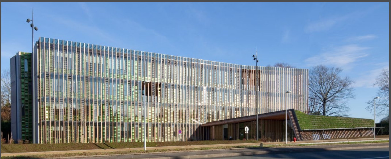
The glass shell on the south façade acts as a buffer: in winter it collects solar heat, in summer it lets Atlantic breezes in. Photos: M. Choiselet Die Glashülle vor der Südfassade dient als Puffer: Im Winter sammelt sie Sonnenwärme, im Sommer lässt sie den Atlantikwind hindurch.
