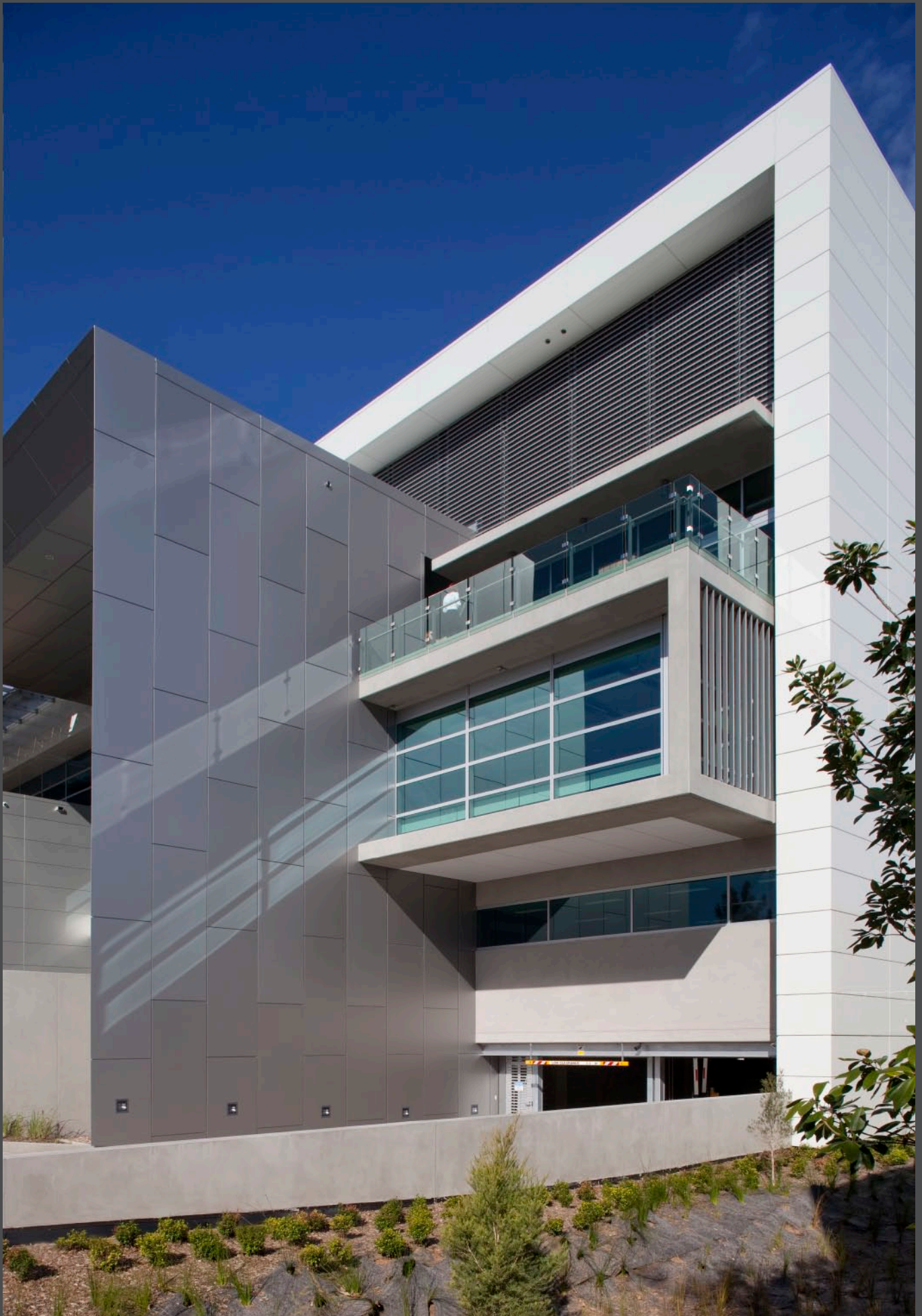
Different buildings interlink on the campus. Each one has its own surface feel, appearance and surface in ALUCOBOND®. Photos: DEM Auf dem Campus verschränken sich verschiedene Baukörper ineinander, jeder mit seiner eigenen Haptik, Optik und ALUCOBOND®-Hülle.
