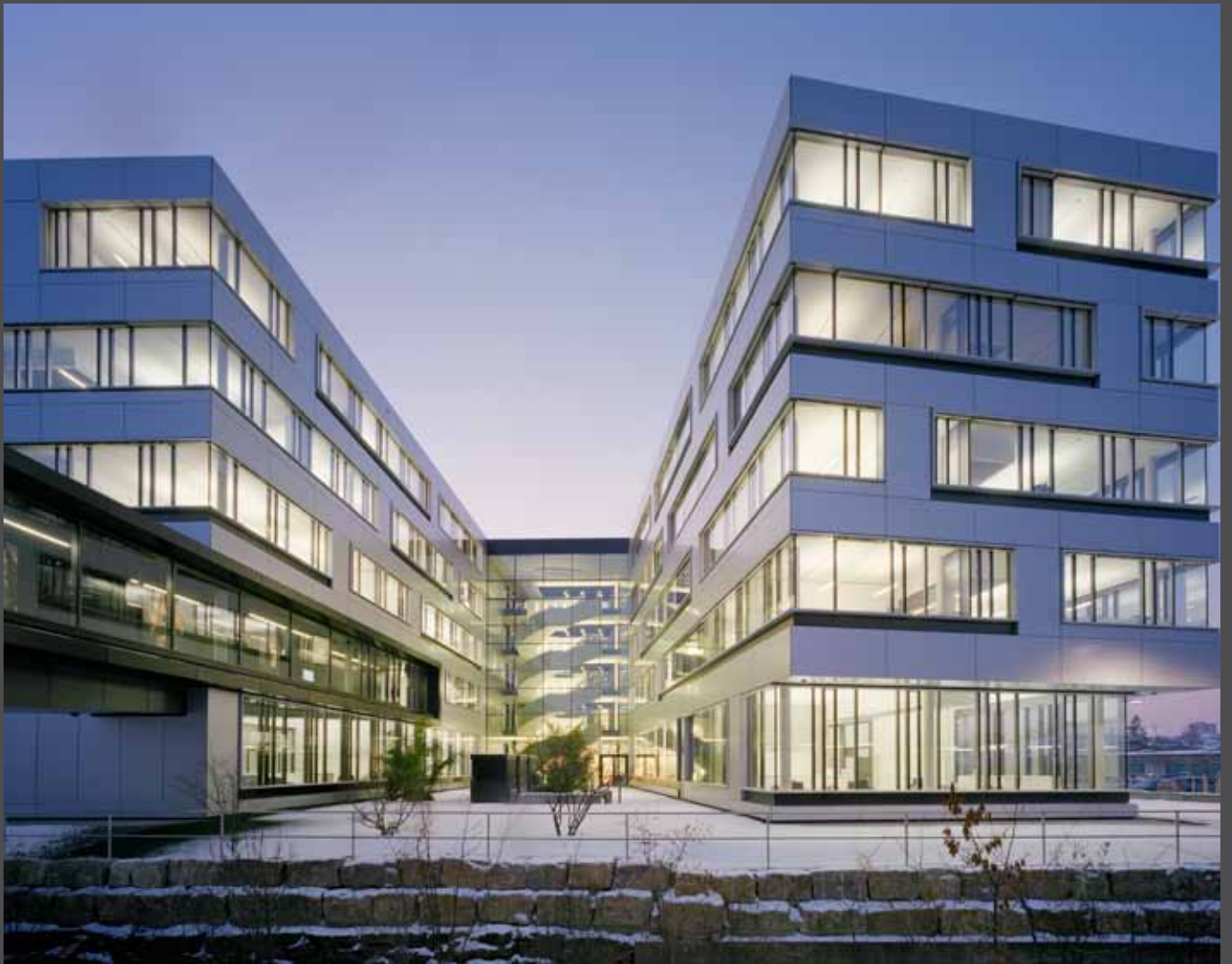
The form of the building reflects the dynamics and zeitgeist of the company. Die Form des Gebäudes spiegelt Dynamik und Zeitgeist des Unternehmens wider.
