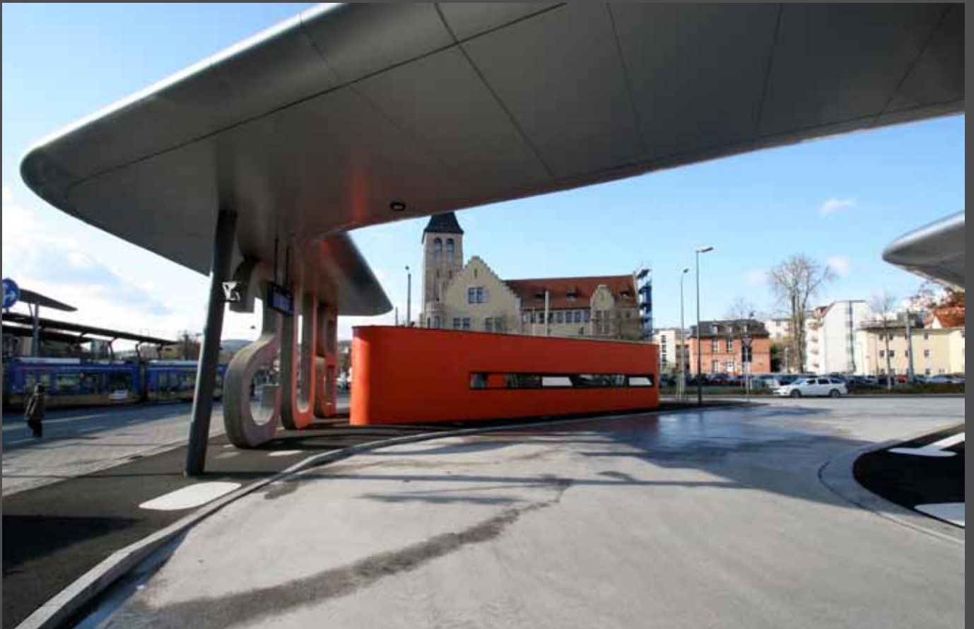
Alongside the concrete letters a break room for employees. Der Personalraum neben den Betonbuchstaben.
