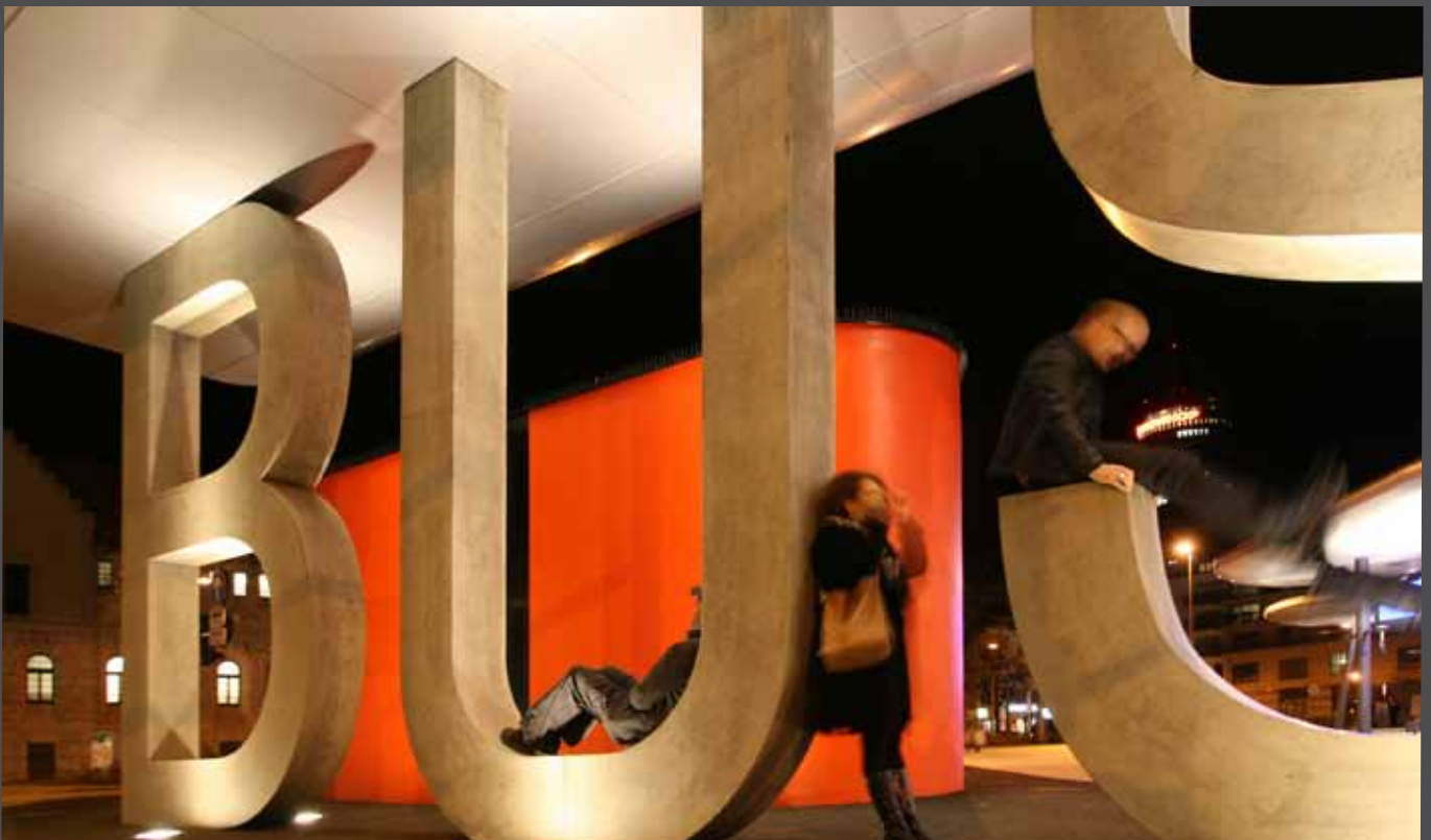
The concrete letters support the spectacular roof Die Buchstaben aus Beton stützen das spektakuläre Dach.
